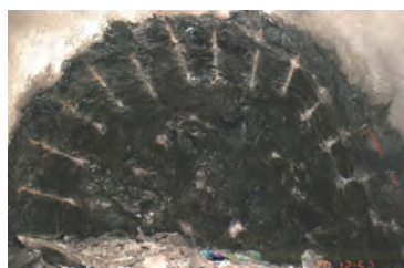
SB発破のノミ跡の例
